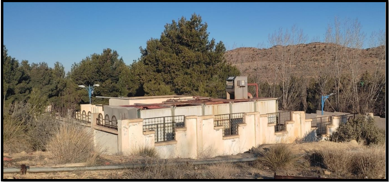
Figure N°15 : station d'épuration des rejets liquides de l'EPH Ahmed Ben Bella
